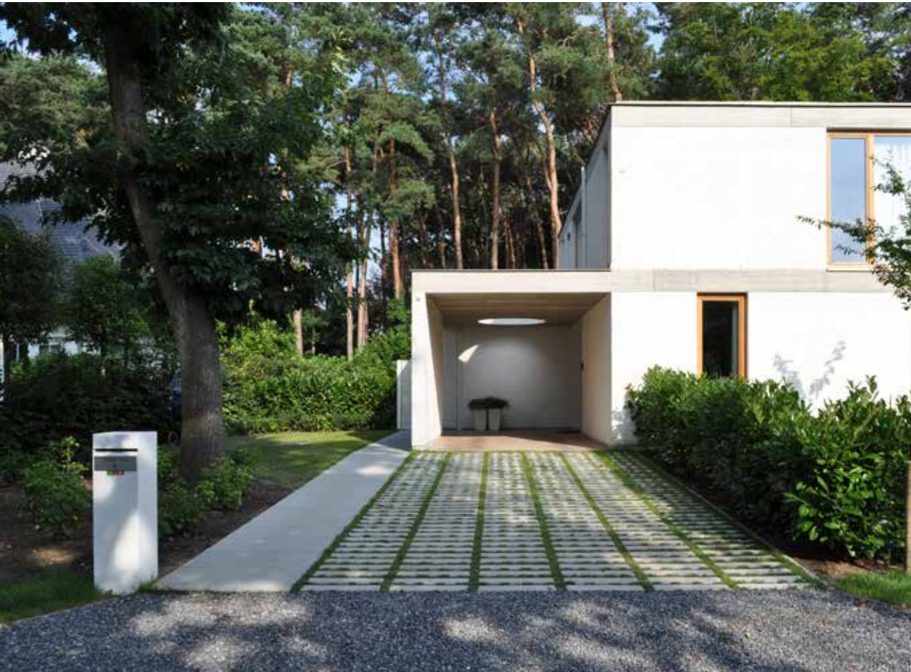
Waterdoorlatende inrit met Grasslines Big, met grasvoegen.
