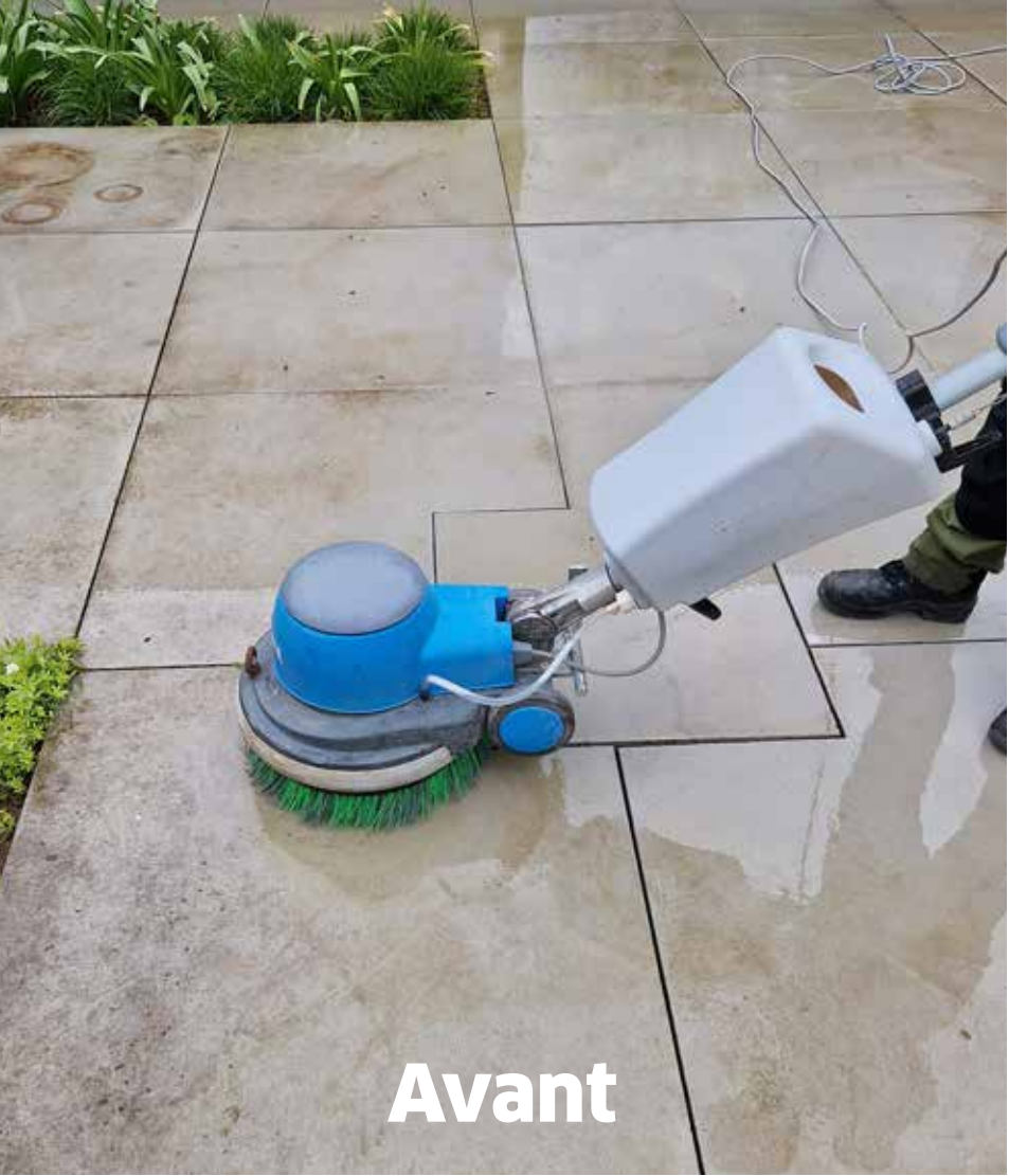
Nettoyage des Megadalles Smooth 100x100x6cm Grey Velvet avec Lithofin MN-Nettoyant extérieur et brosse Terrazza.
