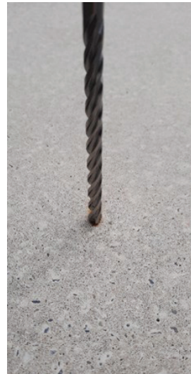
Behandel een pyrietvlek liefst vanaf de beginfase Bepaal de pyrietkern
