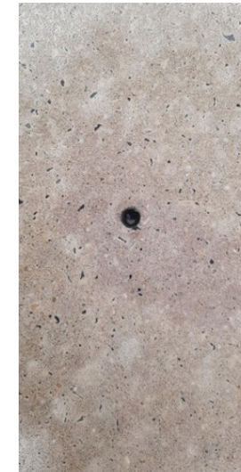
Dit is het resultaat na het uitboren en nadat de roest uit de poriën gehaald is dmv Lithofin Rost-Ex
