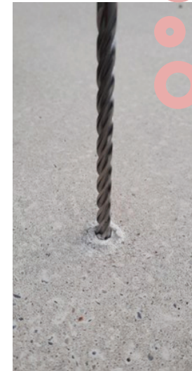
Boor de pyriet eruit met behulp van een kernboor, dia 10-15mm
