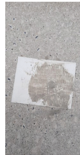
Laat de herstelpasta voor ongeveer 2 uur uitharden
